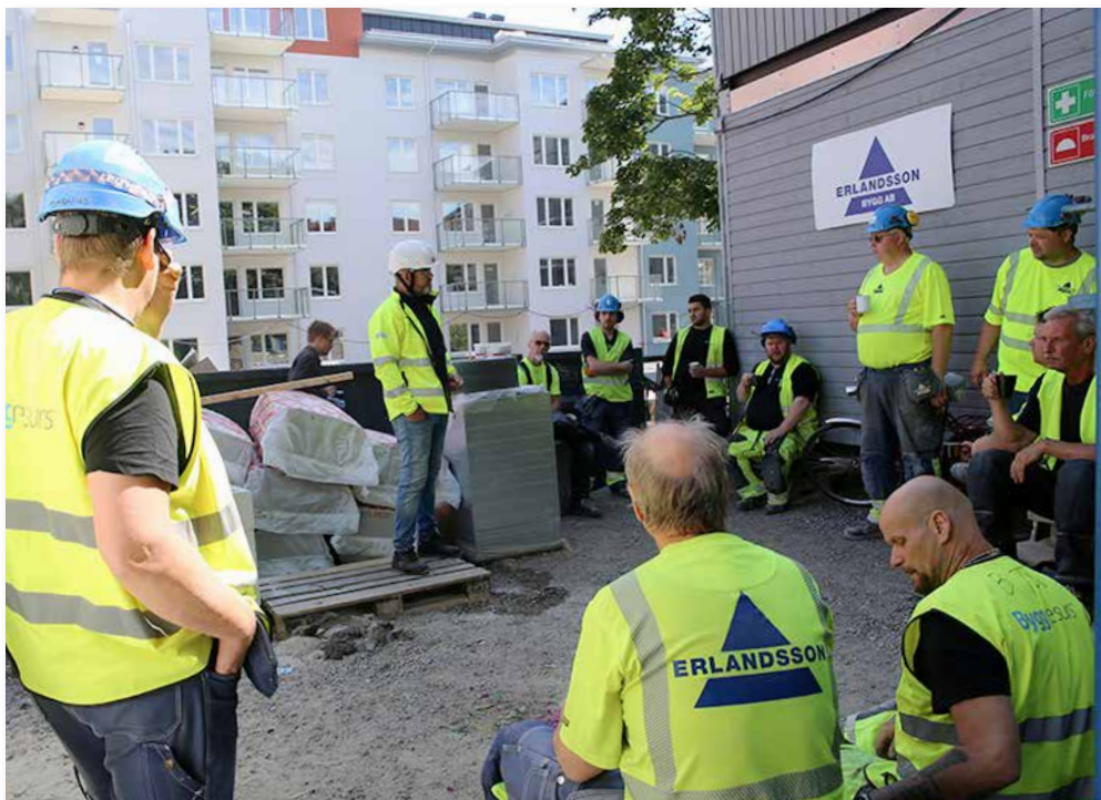
Byggtugg. Under året prioriterade ordförande Johan Lindholm att träffa medlemmar. Han besökte arbetsplatser och pratade fackliga frågor, vilket både livesändades på Facebook och uppmärksammades av media. Här besöker han en byggarbetsplats i Norrköping under Almedalsveckan.
