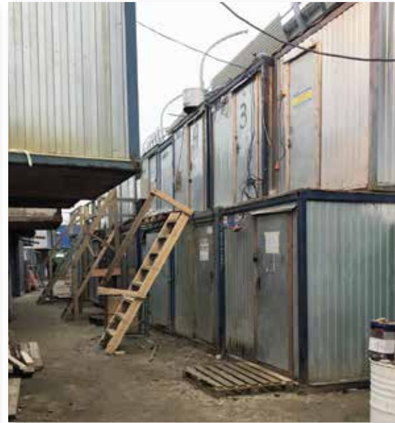
Undermåliga villkor avseende arbetsmiljö och boende upptäcktes på ryska arenabyggen.
