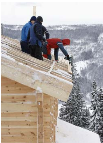
Baltiska byggnadsarbetare någonstans i Åretrakten.
