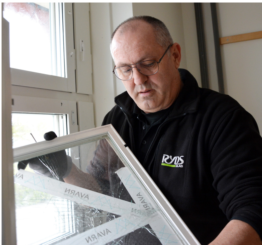
Glasmästaren Hajrudin Durakovic byter en fönsterruta på en skola i Malmö.
