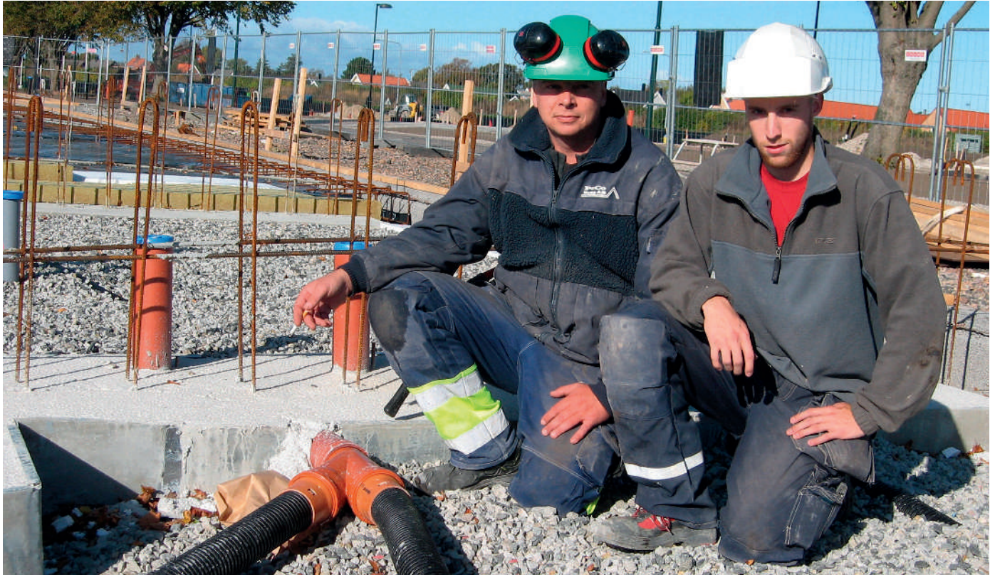
Patrik och Glenn lägger ut Bituthenemattor för att hindra markradon att tränga genom den gjutna plattan till dom 31 lägenheter som JM bygger på området Gyllins trädgård. Lägenheterna ska vara inflyttningsklara sommaren 2010.
