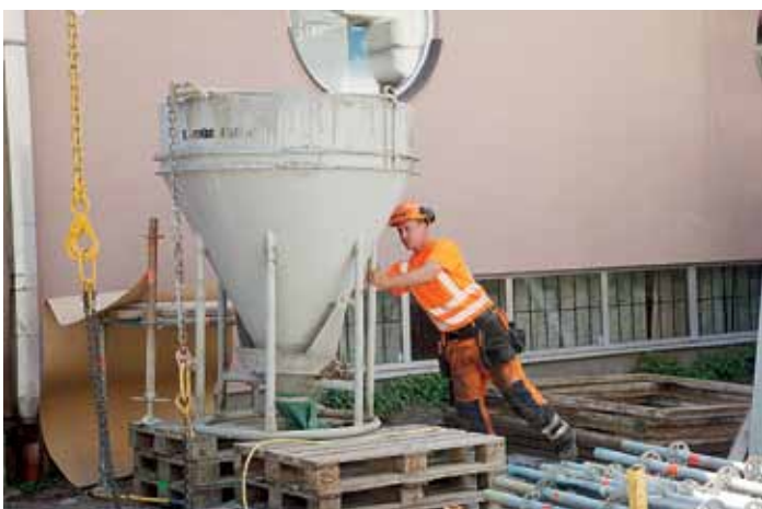
Lagbasen Peter Tomasson hjälper kranföraren att få betongbehållaren på plats för ett lyft.
