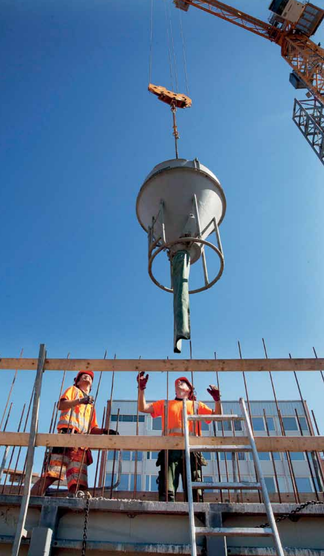
Dags att gjuta. Det krävs precision för att få den så kallade baskern på plats.
