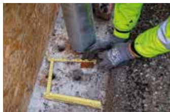
Bron renoveras och ska få nytt räcke. Då behövs nya hål tas i betongen
