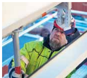
Jörgen Jensen monterar glaspartier till fasaden.
