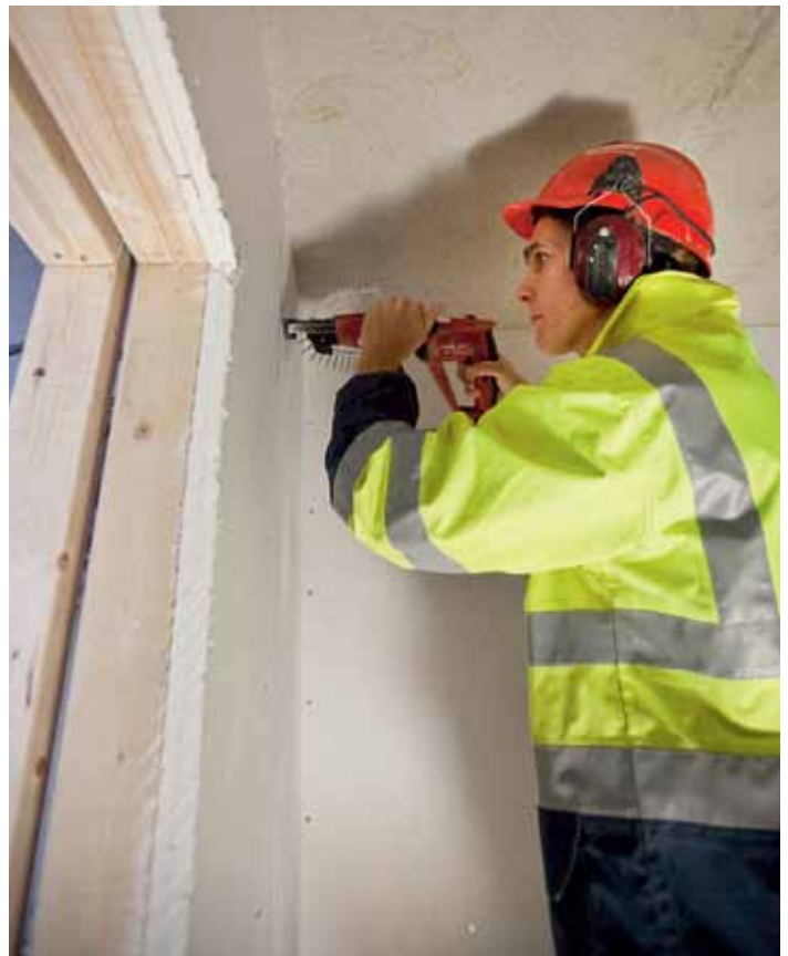
Andreas Åhs spikar gips i ett kommande badrum. "Det är ett bra och välplanerat bygge," säger han.
