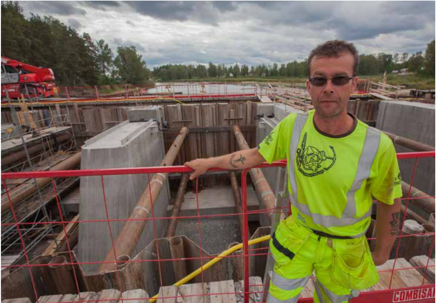
Betongaren Görgen Evertsson uppskattar att det är tre månader kvar på första etappen. Sedan byggs en likadan etapp av dammbygget på motsvarande sida.
