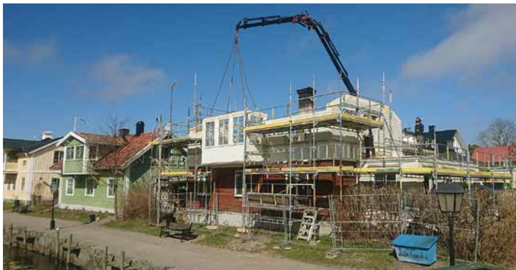
Här monteras en höjning av taket i en villa i Trosa.
