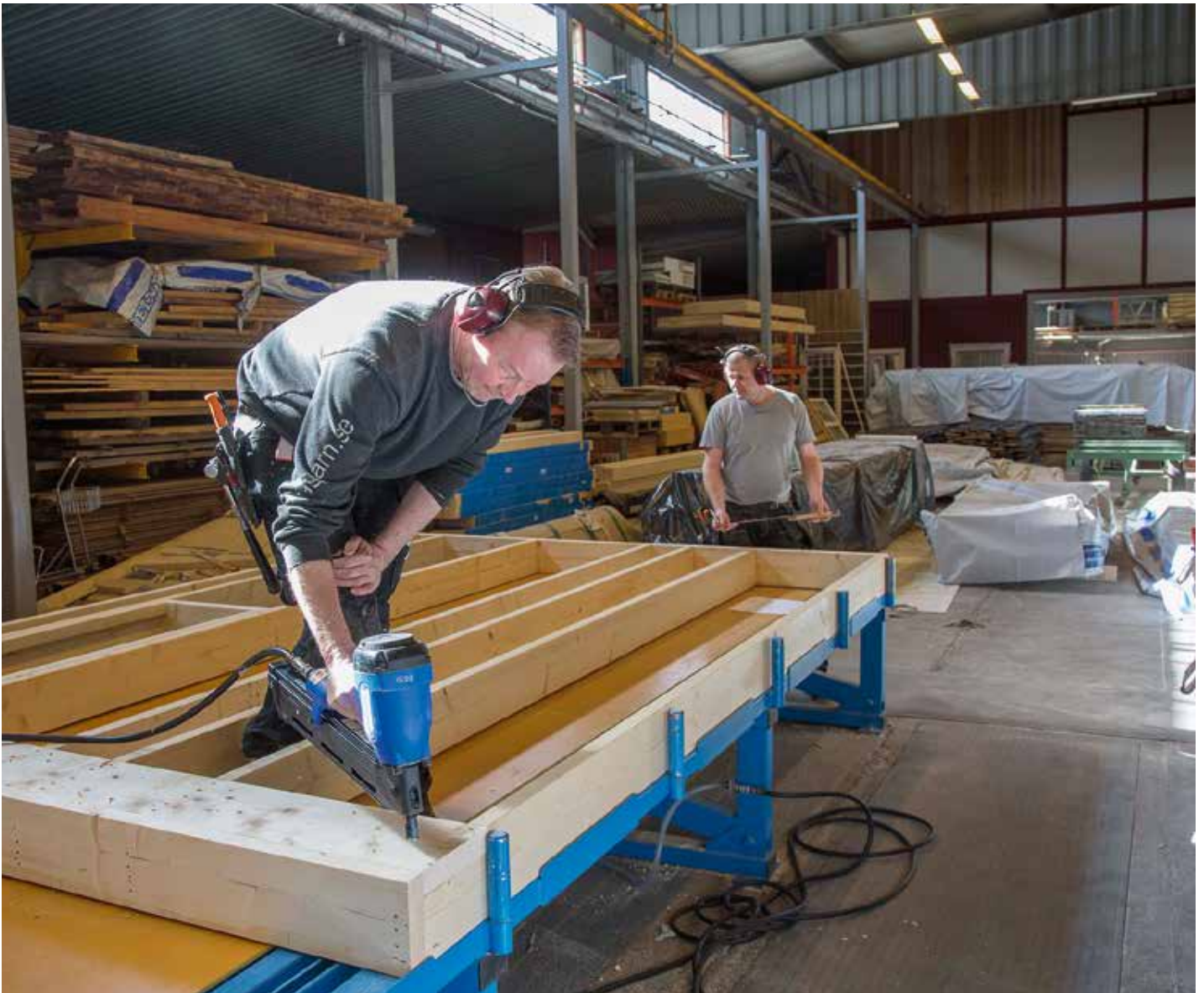
Här tillverkas ett väggelement till en villa i fabrikationshallen, från vänster snickarna Anders Olsson och Bengt Febring.
