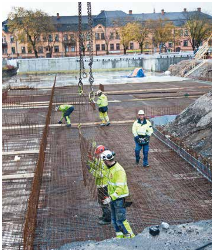
Regeringen vill lagstadga om entreprenörsansvar för bygg- och anläggningsbranschen. Det är Byggnads mycket positivt till.
