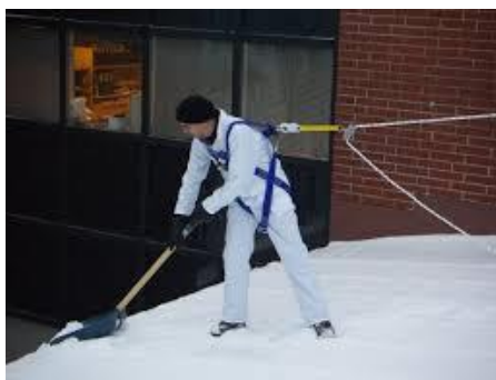
Förankringslina med falldämpare
