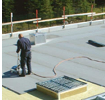
Figur 22b. Skyddsräcke monterat i sarg. Observera för lågt skyddsräcke
