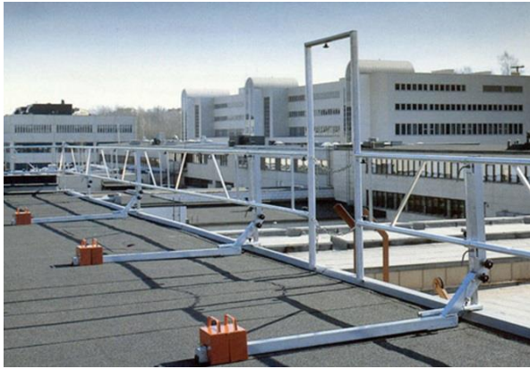
Figur 22a Motviktsystem Zip-Up. Observera för låg fotlist.
