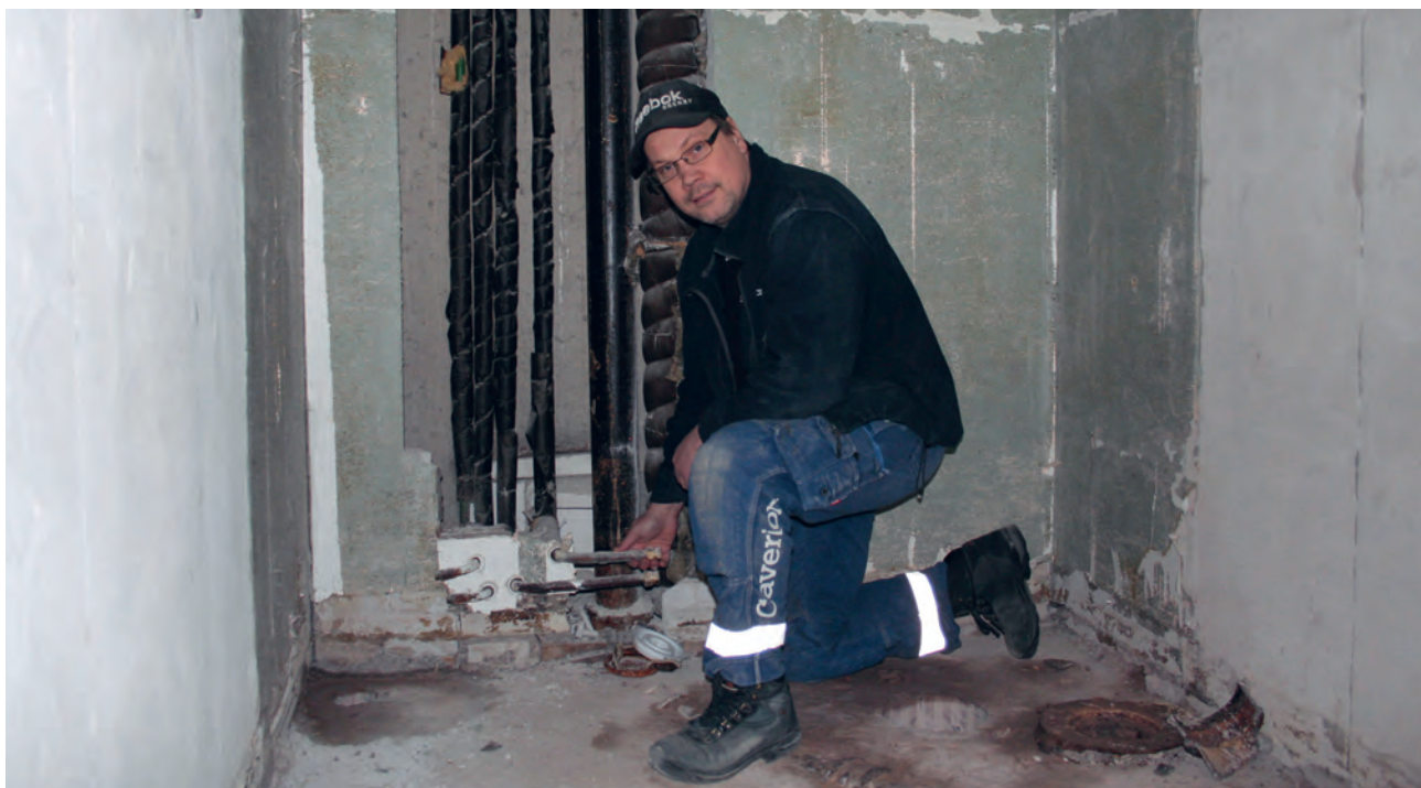
Mats i ett badrum där rören runt väggarna är rivna. Nu skall även stammarna bort innan det är dags för nymontering.
