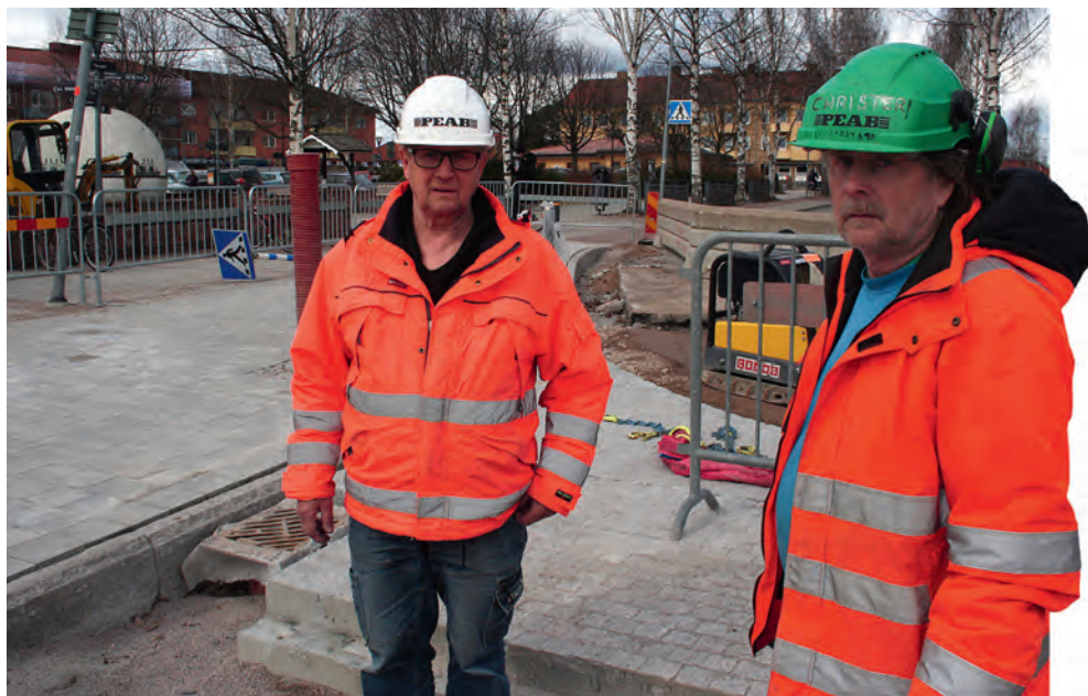
Platschef Bo-Göran Rindberg och Christer Hansson framför en del av stenläggningen i Leksands centrum, ett arbete som pågått sedan sommaren 2016 och skall vara klart till midsommar i år.
