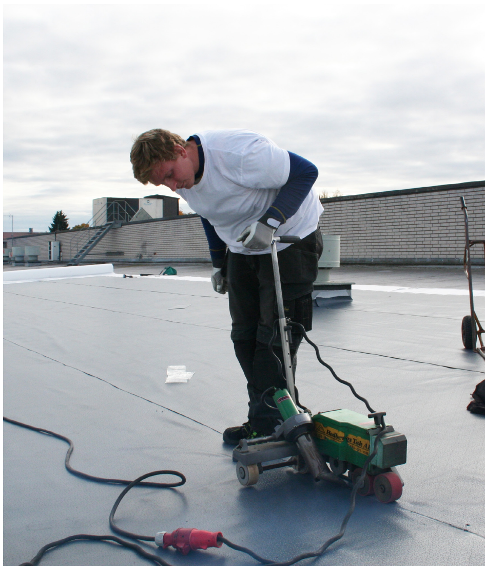
Med hjälp av en maskin på hjul som avger 480 graders värme ser Mikael Pettersson till att skarvarna på taket kommer att hålla tätt.
