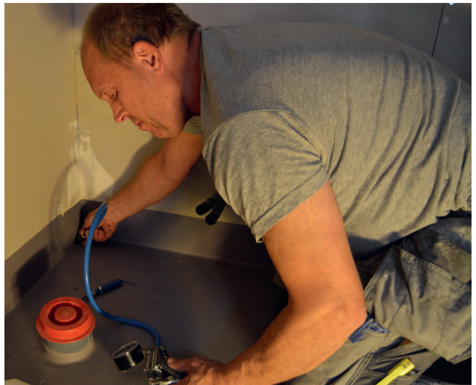
När svetsningen av mattan är gjord är det dags för Pecka att kontrollera arbetet genom att vakuumtrycka skarven för att försäkra sig om att skarven är tät.
