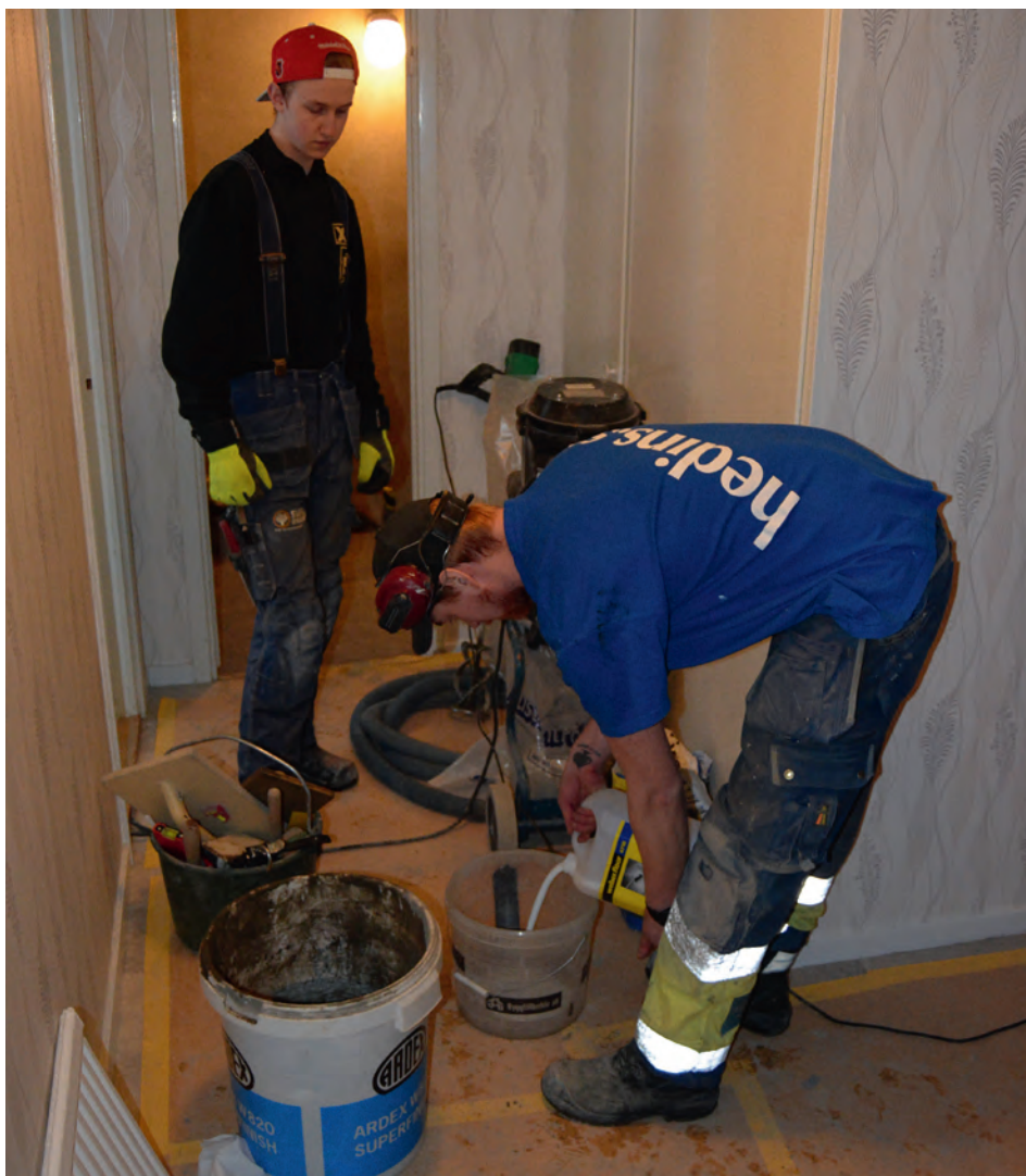
Patrik förbereder sig för att påbörja behandlingen av ett badrumsgolv under överinseende av praktikanten Joakim Andersson.
